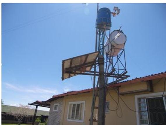
**Foto 5.** La energía eléctrica solar abastece el ordenador y otros pequeños electrodomésticos; la calefacción de agua también solar
