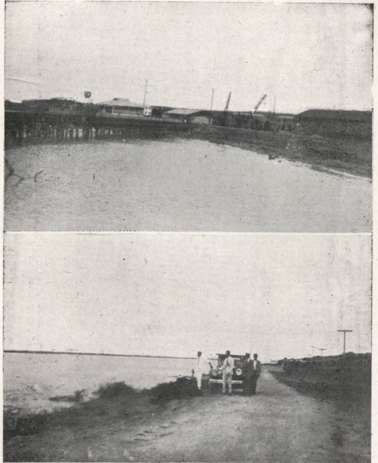
COLOMBIA DESARROLLA SUS PRODIGIOSAS RIQUEZAS NATURALES. MUELLES EN CONSTRUCCIÓN DE LAS BOCAS DE CENIZA (BARRANQUILLA) EN LA DESEMBOCADURA DEL RIO MAGDALENA Y CARRETERA DE BARRANQUILLA A DICHAS BOCAS
