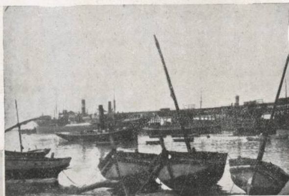
DIRIGIÉNDONOS HACIA EL GRAN VIADUCTO DE RIO-TINTO.
