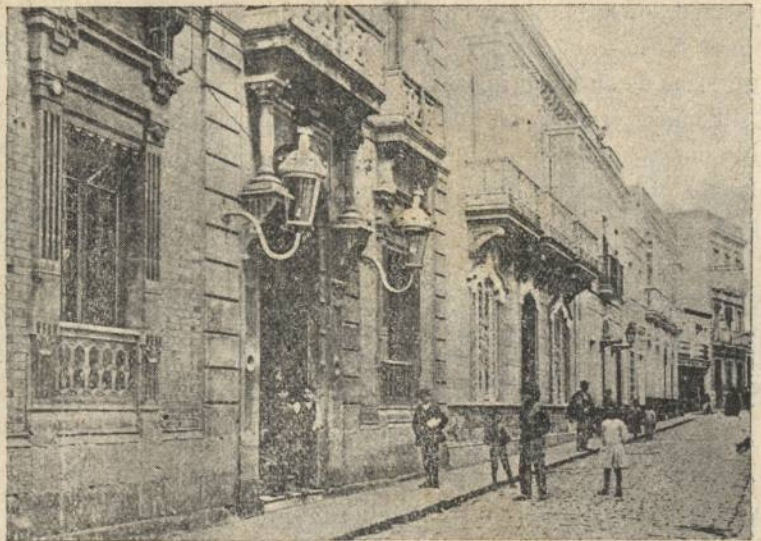
HUELVA.—Magnífico edificio del Círculo Mercantil situado en la calle Castelar
