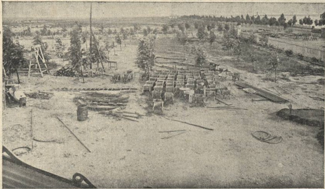
PUERTO DE HUELVA.—Zona terraplenada disponible
