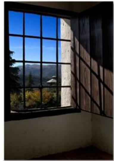
Ilustración N° 9. Captación directa de calor
