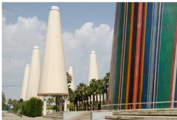
Ilustración N° 12. Torres de enfriamiento evaporativo. Av. Europa Expo 92 - Sevilla
