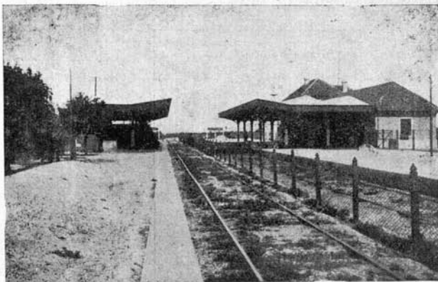
VILLA CALZADA. ESTACIÓN DEL SUR
