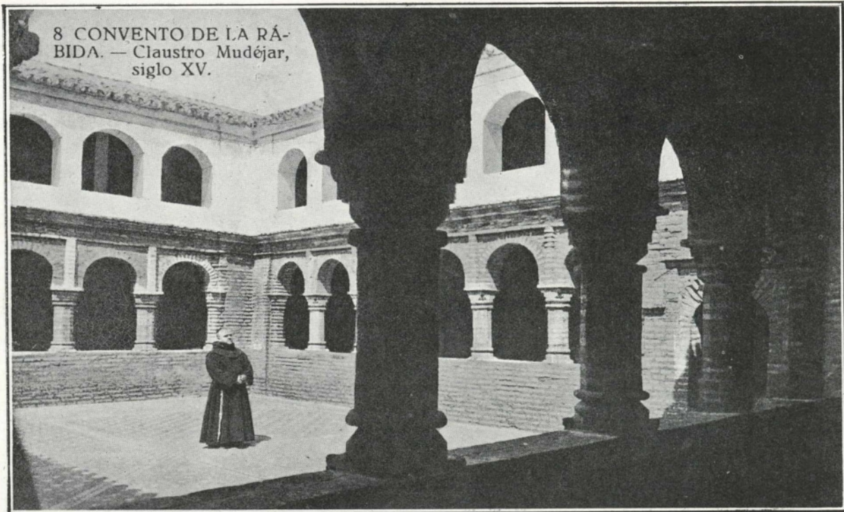
Claustro mudéjar, obra vista desde el claustro de las flores.
