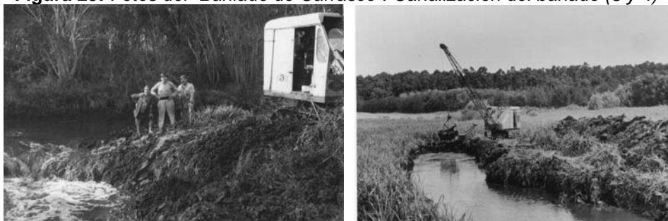
Figura 23: Fotos del “Baniado de Carrasco”. Canalización del bañado (3 y 4)
