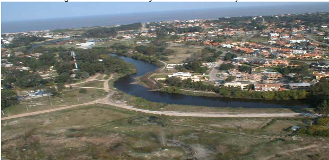
Figura 32: Foto .Márgenes del A. Carrasco y Viviendas-Cuenca Baja
