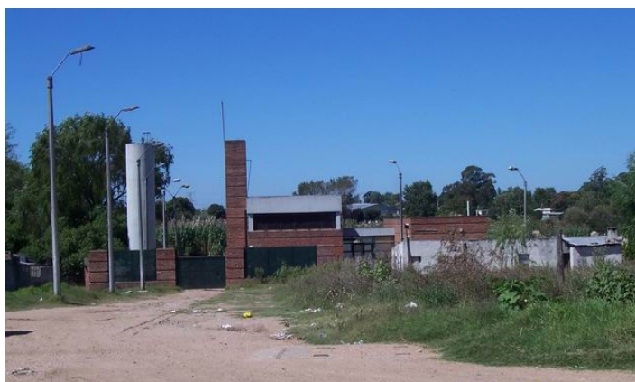
Figura 44: Foto: Estación de Bombeo en Cañada Chacarita.
