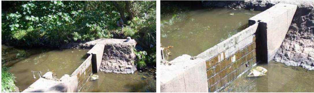
Figura 41: Fotos (4): Estación de Bombeo en Cañada de las Canteras
