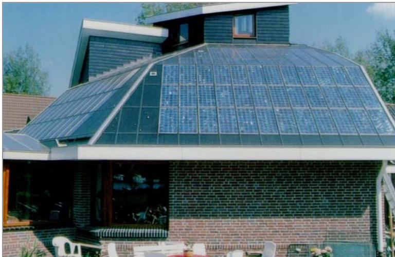
Figura 2.21-Vivienda de nueva construcción (Holanda); Potencia: 3,4 kWp, superficie de captación: 35 m<sup>2</sup>; Módulos FV de Si- policristalino, integración: cerramiento. Fuente: Instituto de Energía Solar, Universidad Politécnica de Madrid
