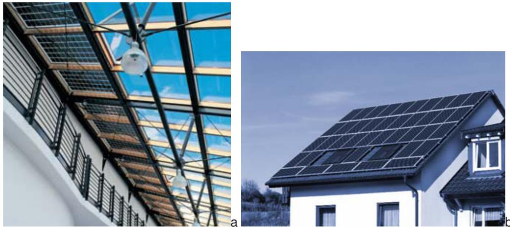
Figura 2.17 - Integración de módulos fotovoltaicos: a-Lucernarios, b –cubiertas
