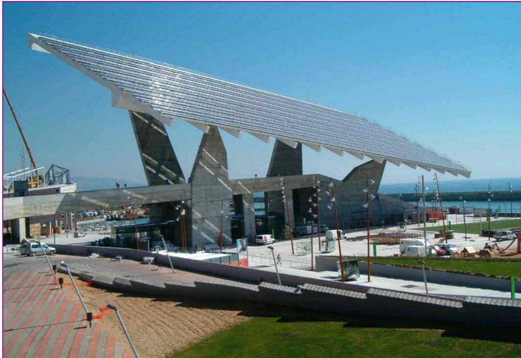
Figura 6.2: Módulos integrados Pérgola “Forum 2004”, Barcelona 500 kWp; Si-monocristalino
