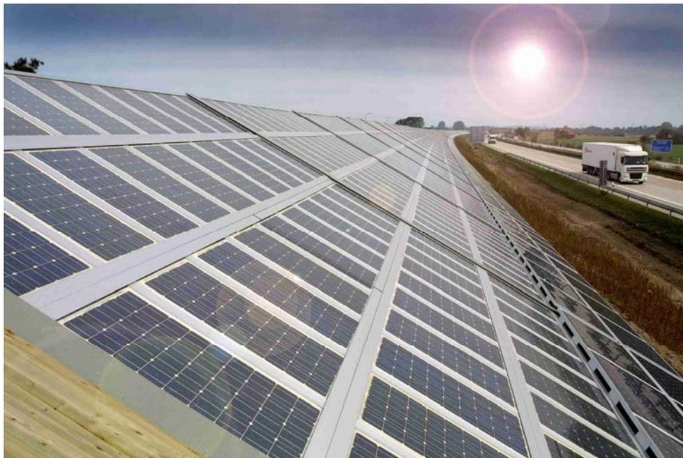
Figura 6.3: Módulos integrados – cerramiento. Barrera antisonido (Stuttgart, 2001)-
