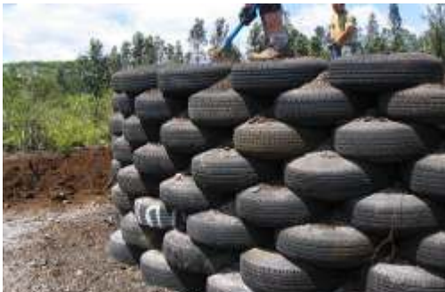
Imagen muro de neumáticos relleno de tierra compactada. Fuente: www.redpermacultura.org
