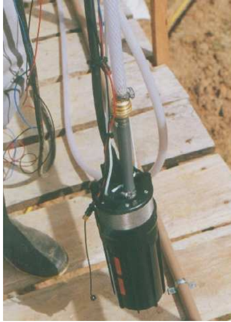
Figura 17: instalación de la bomba Shurflo 9300 13
