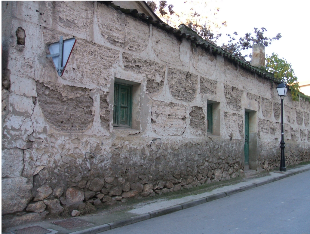
Edificación tradicional en Morata de Tajuña
