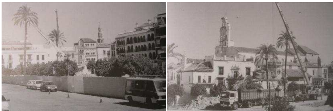
Fases de amurallamiento y retirada de vegetación y mobiliario urbano
