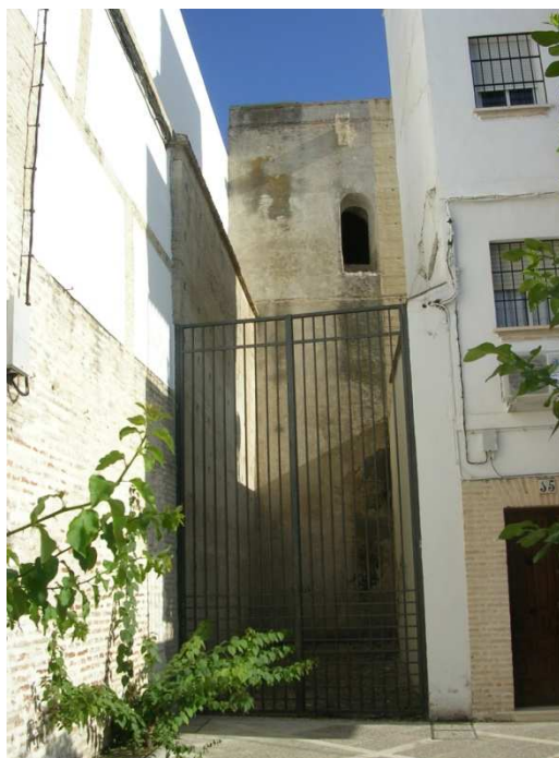
Resto de muralla árabe
