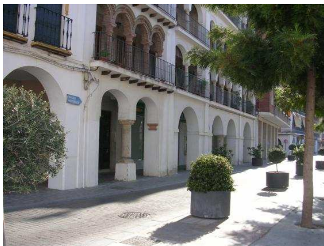
Soportales de la plaza, en los lados este y norte.
