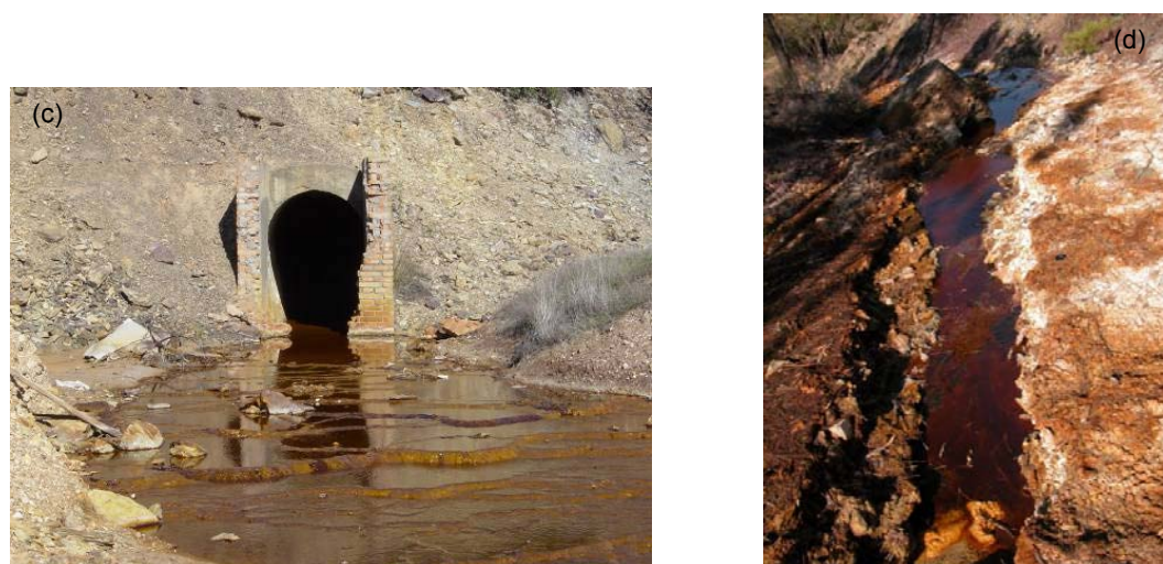
Figura. 9 (c) Túnel por donde discurren los lixiviados de la mina Cueva de la Mora, donde se aprecia la formación de terrazas, y (d) lixiviado procedente del pozo minero (muestra CM4).
