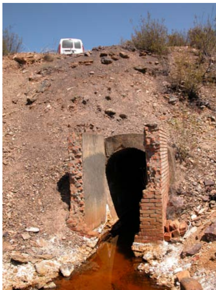
Figura. 2 Salida del lixiviado liberado desde el túnel minero, desembocando en el arroyo Monte Romero.
