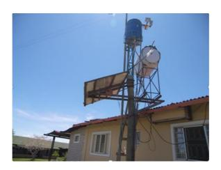
Foto 5. La energía eléctrica solar abastece el ordenador y otros pequeños electrodomésticos; la calefacción de agua también solar
