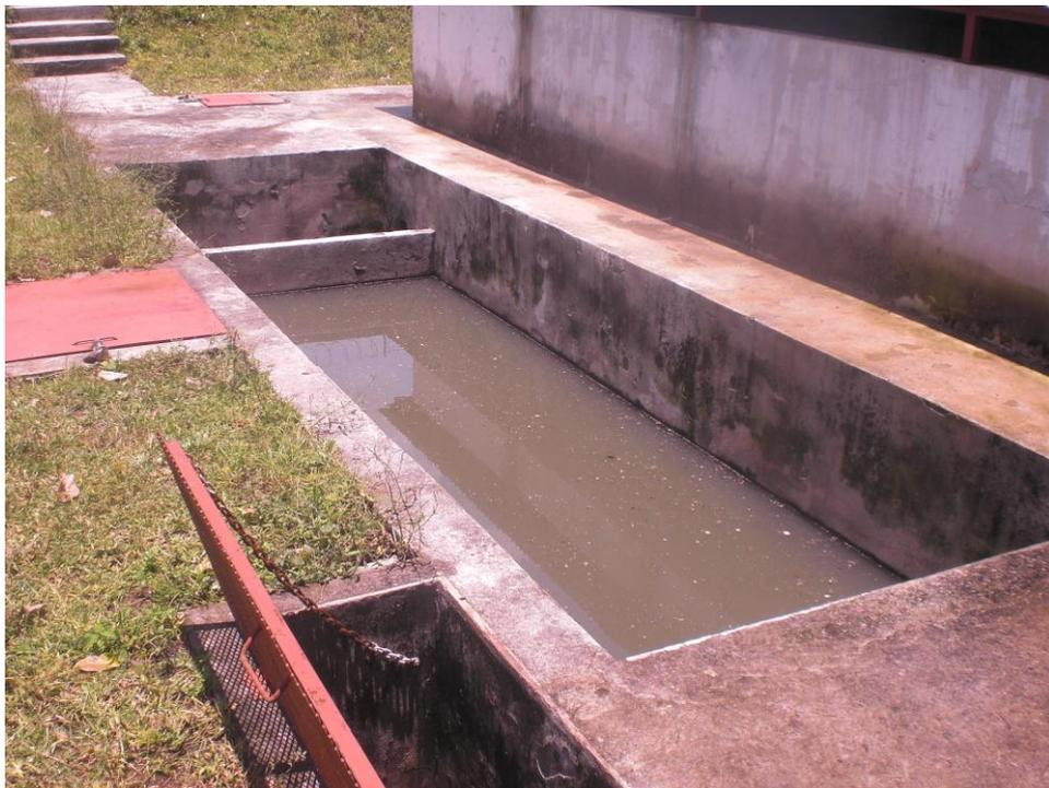
Fotografía N.3. Sistema de rejillas, separador de flotantes y desarenador, Fotografía A. Hidalgo, 2012
