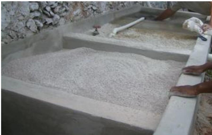
Fotografía N.15.Tanques con zeolitas. Fuente:
