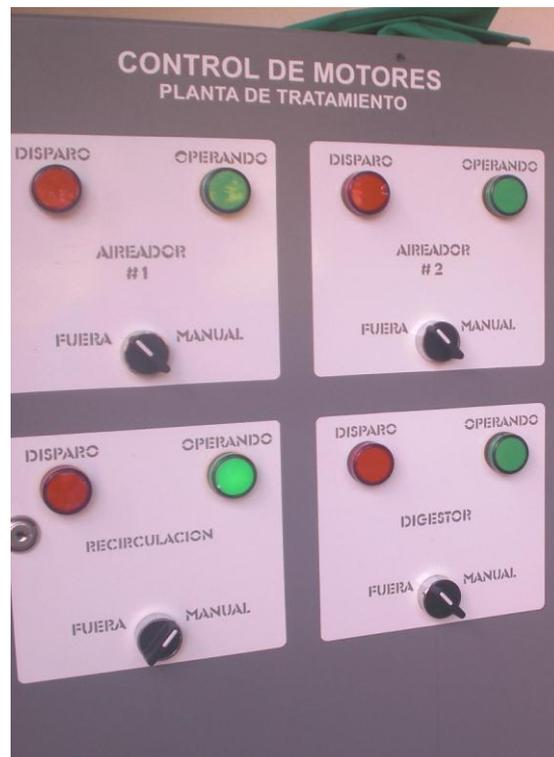
Fotografía N.10. Panel de control de donde se tiene acceso a los sistemas de monitoreo de los aireadores, recirculación y digestor de lodos, Fotografía A. Hidalgo, 2012
