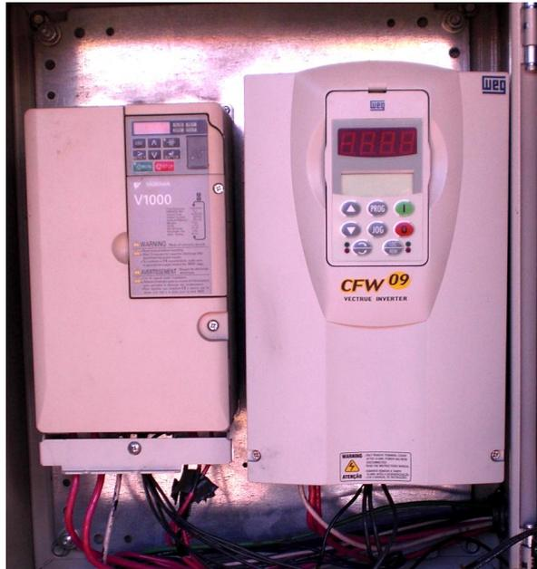
Fotografía N.11. Variadores de frecuencia, utilizado para transformar la electricidad de la fase monofásica a trifásica, uno para cada aireador,
