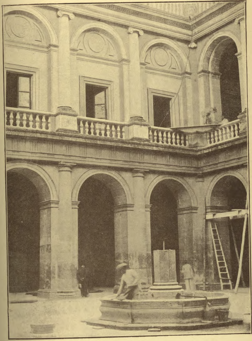
ARCHIVO GENERAL DE INDIAS. - VISTA DEL PATIO.
