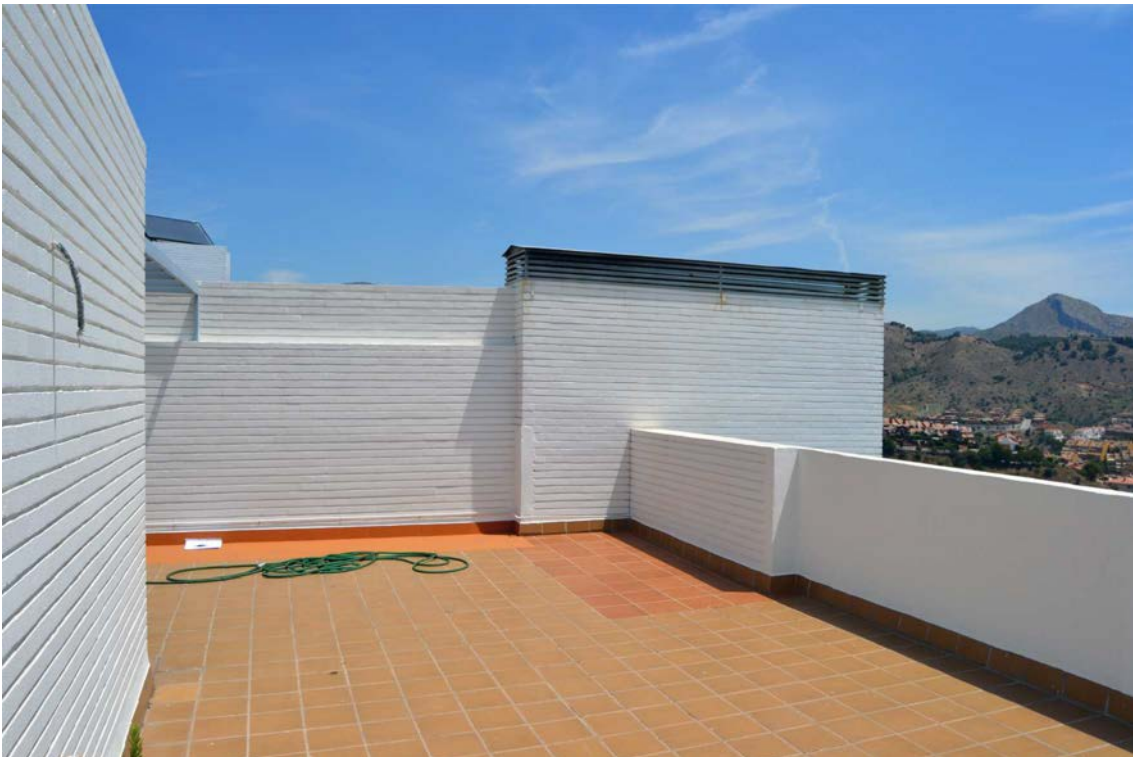
IMÁGENES DESDE LA CALLE TRASERA (ARRIBA) Y DESDE LA PROPIA CUBIERTA (ABAJO)
