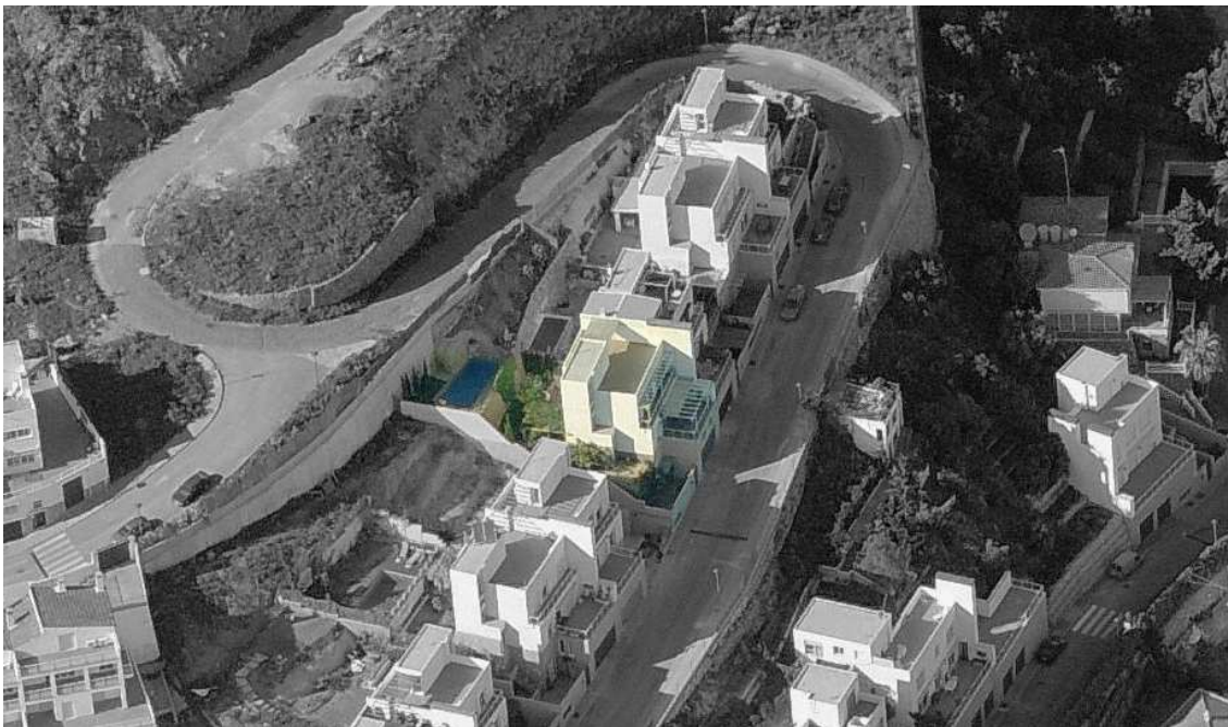
VISTA AÉREA DE LA VIVIENDA OBTENIDA A TRAVÉS DE GOOGLE EARTH
