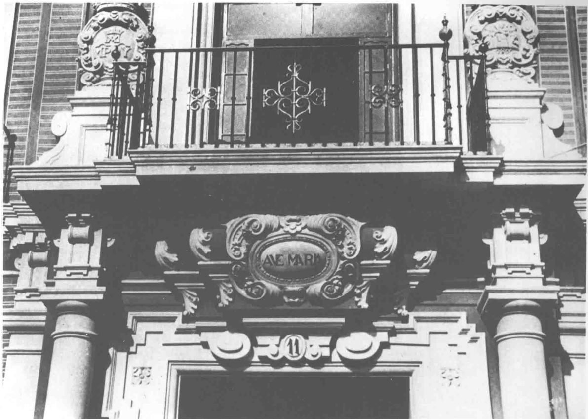
Talavera, 1953. Detalle fachada principal Colegio Escolapio. Plaza Jauregui.
