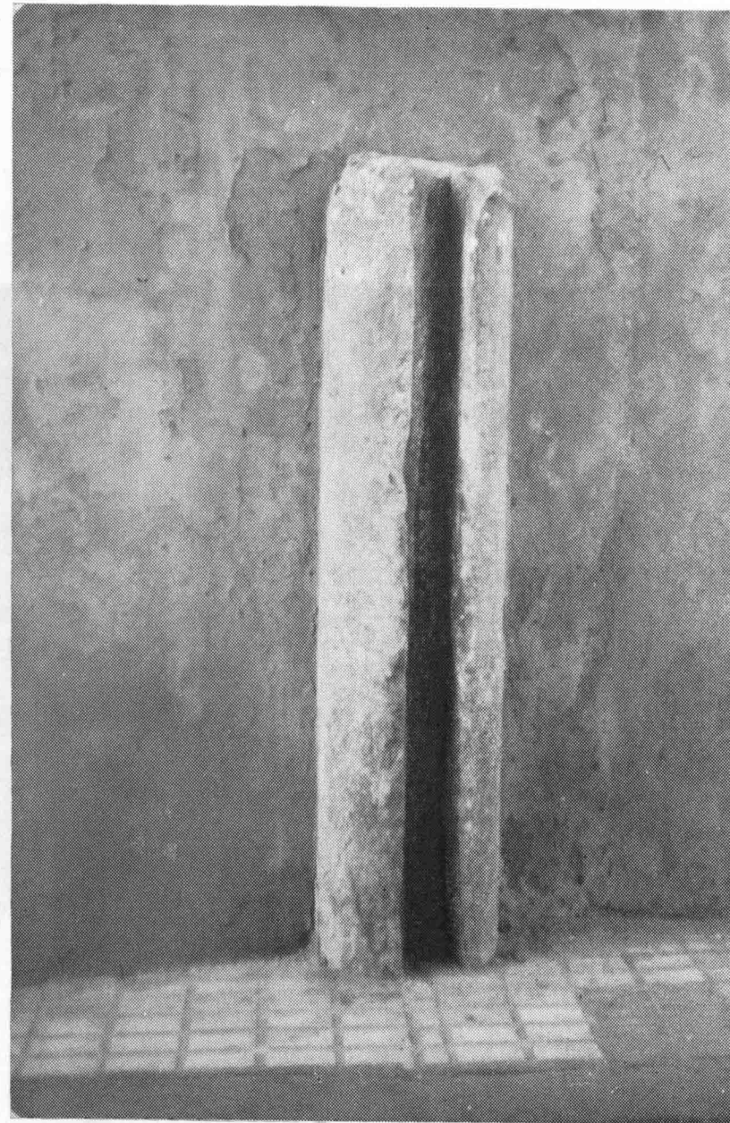
Fig. 9. Columna adosada al muro del «postigo del aceite», con una ranura en la que se introducían las tablas calafateadas para evitar la penetración de las aguas en el espacio urbano, intramuro, en caso de riadas.
