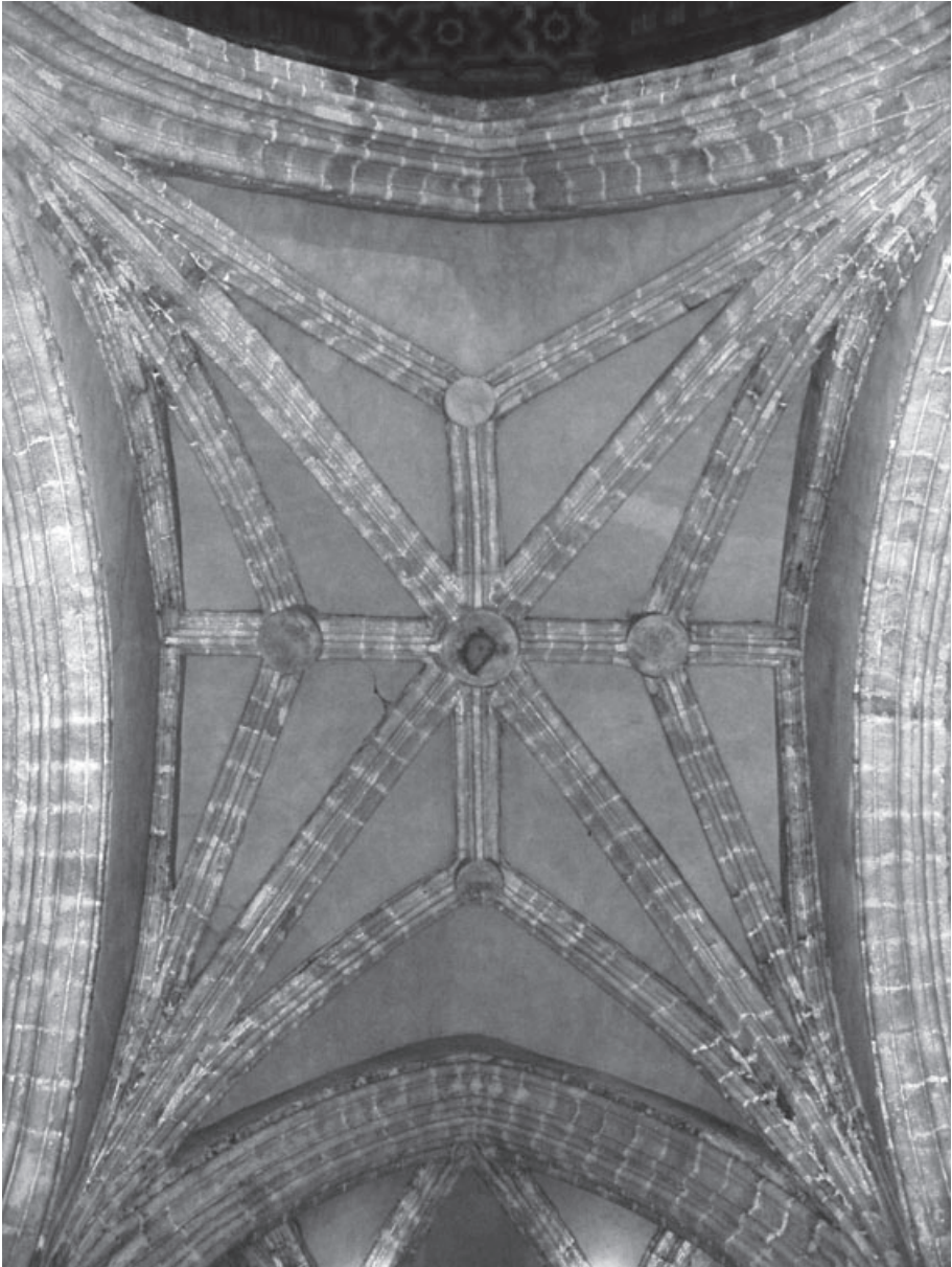
5. La bóveda central del crucero
