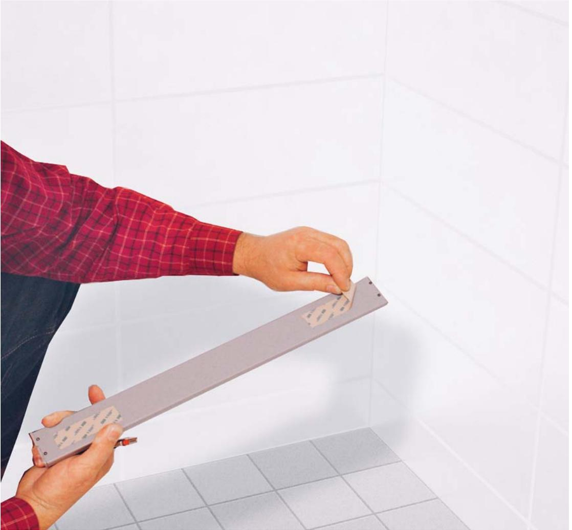
El detector puede ser instalado con cinta de doble cara o atornillado
