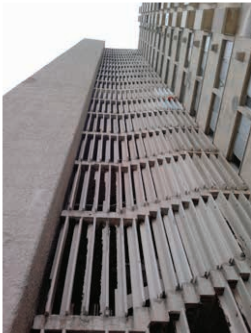
Figuras 10-11: Edificio de apartamentos situado en F y Malecón, Arq. Antonio Quintana y Alberto Rodríguez. (Imágenes de la autora)
