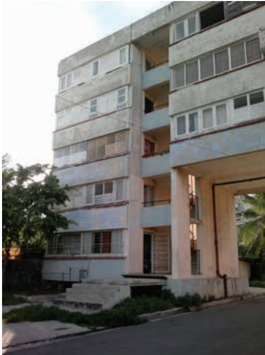
Figuras 12-13: Edificio de apartamentos experimental construido con el sistema constructivo LH. (Imágenes de la autora)
