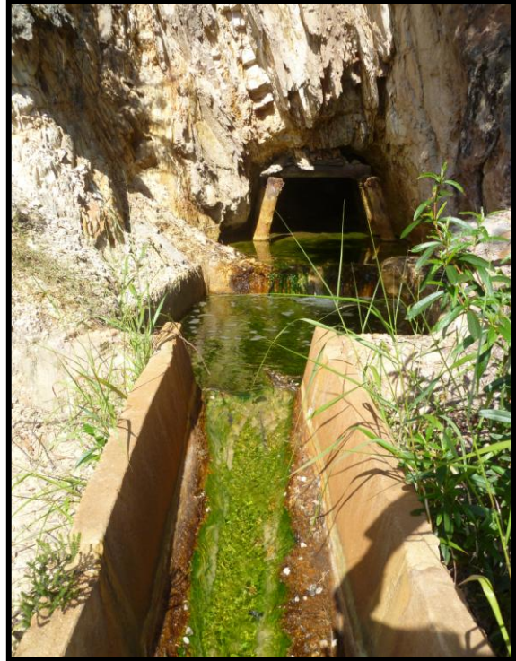
Fig. 3 Vista General de Bocamina.
