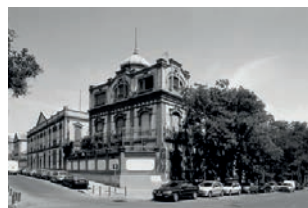
Figura 10. Laboratorio Central de Farmacia construido por el ingeniero militar Pascual Fernández Aceituno, en 1920. A partir de 1950 se denominó Instituto Farmacéutico de las Fuerzas Armadas y Academia de Farmacia Militar. Colegio Oficial de Arquitectos de Madrid. Inmueble F2.175.
