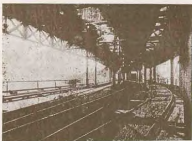
UN DETALLE DEL COLOSAL MUELLE DE LA COMPAÑÍA DE RÍO-TINTO EN EL PUERTO DE HUELVA
