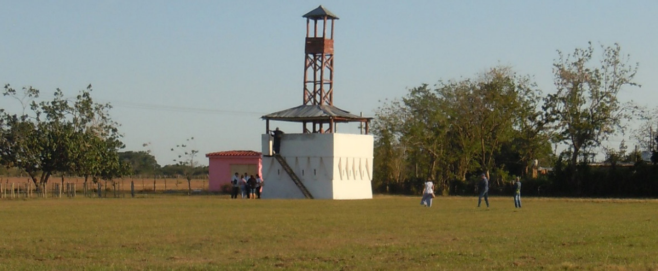
Imagen 1. Fortín y alambrada en el tramo restaurado de La Trocha en Ciego de Ávila. Archivo personal.
