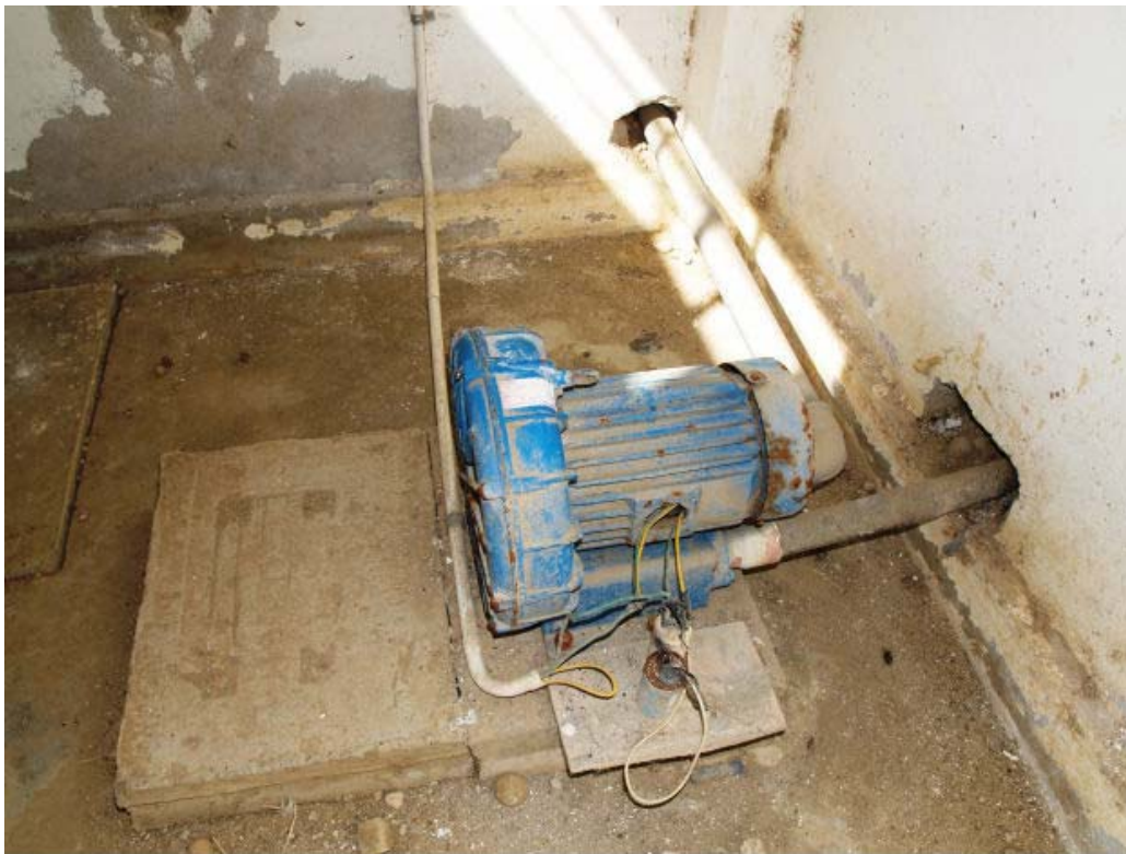
Fig. 4. Blower de 3 HP usado durante le fase de experimentación
