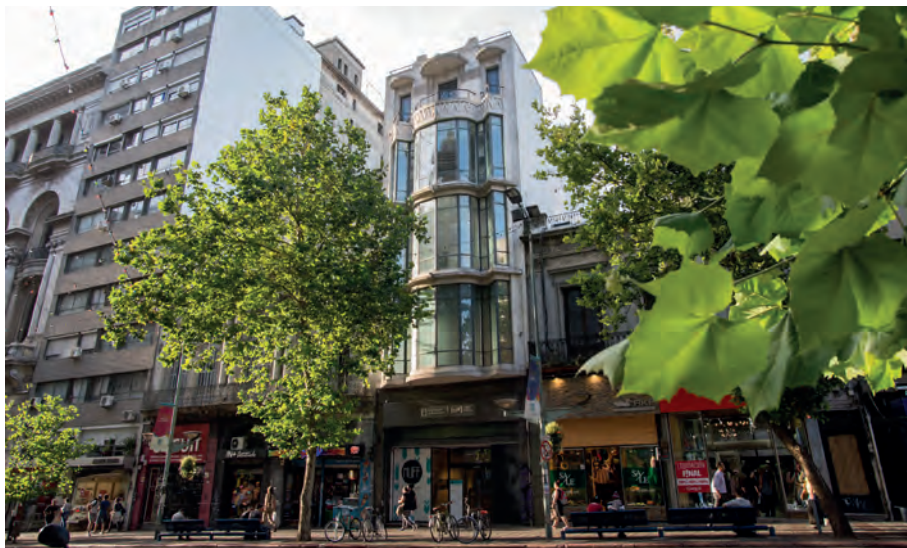
Figura 1. Edificio Sede del Centro de Fotografía
