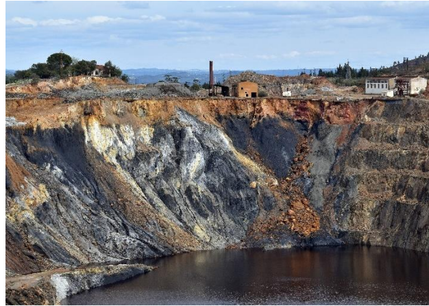
Figura 15 Tharsis-Filón Norte-Instalaciones (Córdoba-García, 2016)
