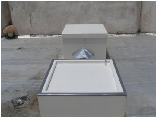
Figura 3-26. Estanque metálico cerrado.
