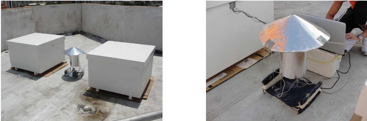
Figura 3-9. Dispositivo de medición de temperatura y humedad ambiente (detalle)
