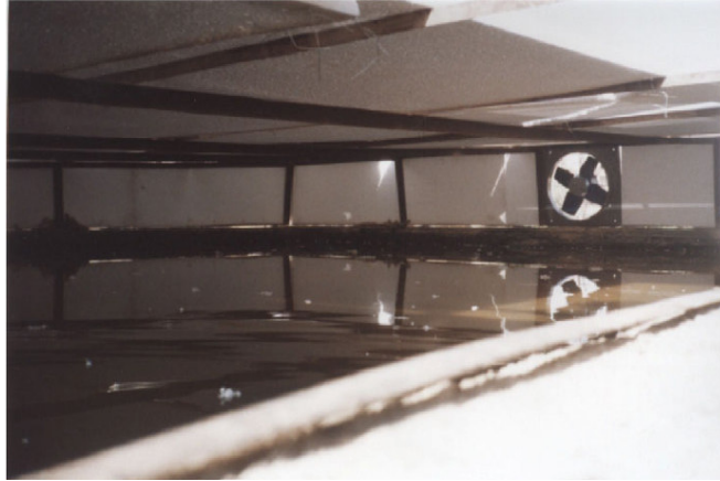
Figura 2-4. Comportamiento térmico de techo estanque con ventilación eléctrica.
