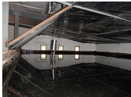
Figura 2-9. SPEEI en techo de la VBP-1.
