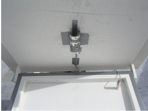
Figura 3-34. Instalación de sensores Toe y Tw2.
