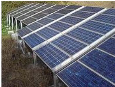
I._ 7 Batería de paneles solares.
