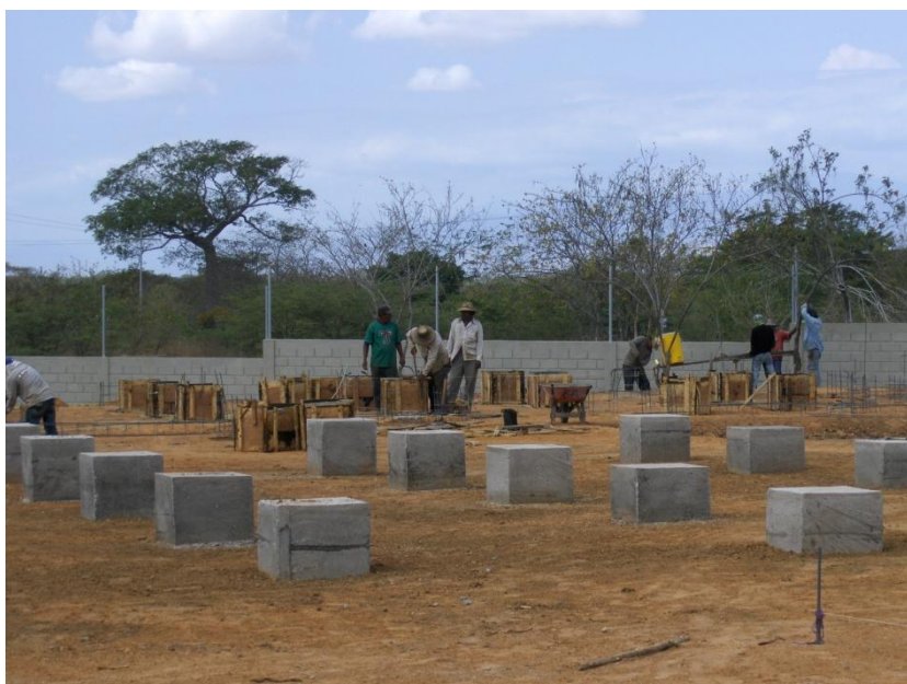
I._87 Construcción de Fundaciones
