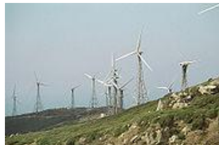
I_ 8 Aerogeneradores Eólicos
