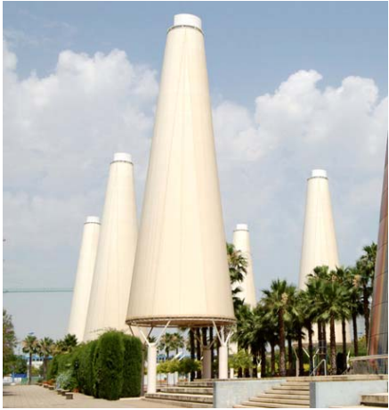
Torres de enfriamiento. Expo Sevilla '92
