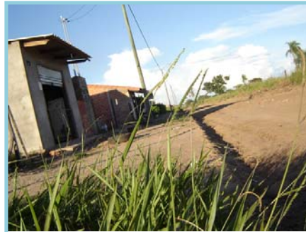
Urbanización popular de baja densidad. (Alejada del área de concentración urbana)
