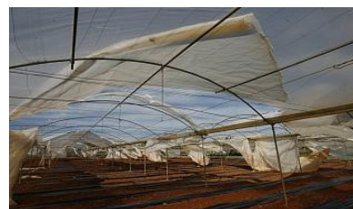
Ilustración 17: cubierta dañada
