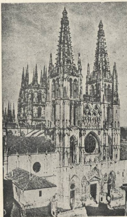
LA CATEDRAL DE BURGOS. LAS CALADAS AGUJAS SE ESTÁN REPARANDO ACTUALMENTE.
