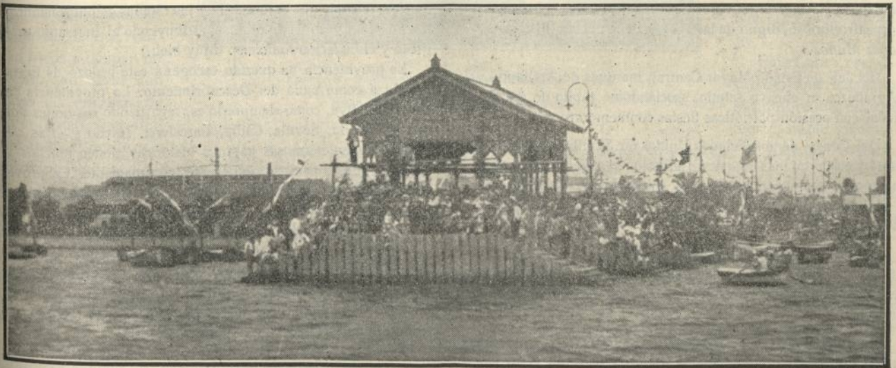
Aspecto de uno de los muelles del Puerto
