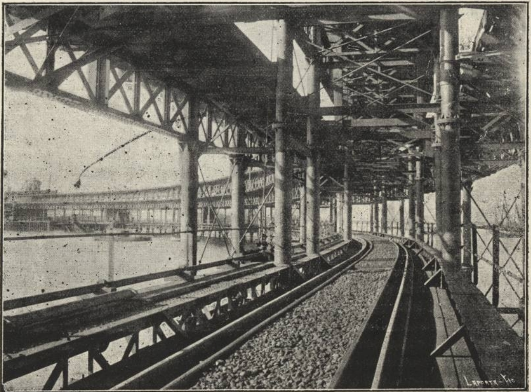
HUELVA. —Soberbio muelle de embarque de la Compañía de Rio-Tinto. Uno de los 7 que tiene el puerto.
