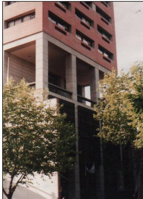
Utilización del hormigón en la estructura, combinado con ladrillo y carpinterías metálicas
