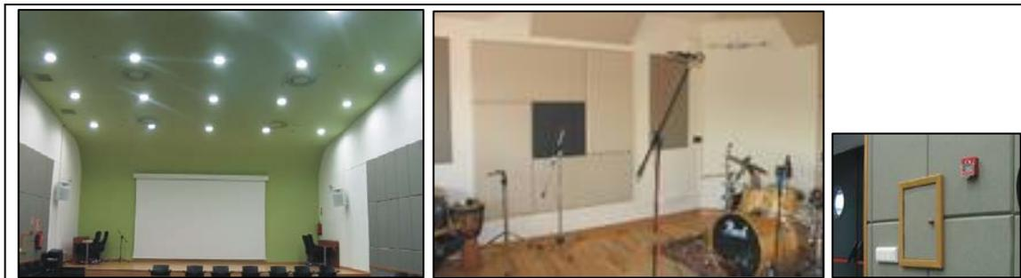
Figura 11. Salas con resonadores de membranas simples para frecuencias bajas
