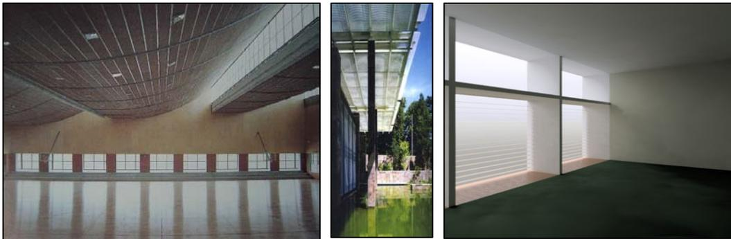
*Figura 8.* Componentes de paso cenitales y componentes de control: pantallas rígidas
