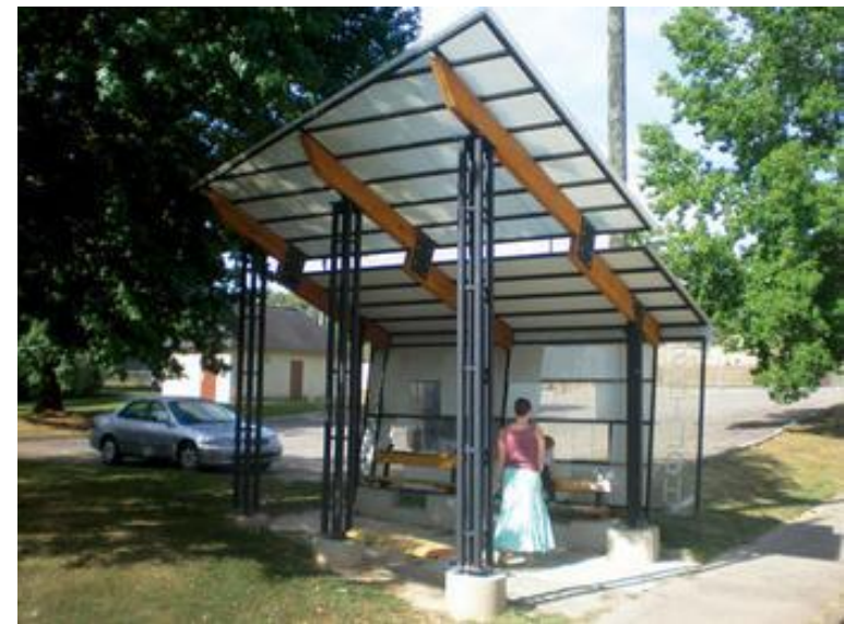
Fig. 38. Paradero de bus en Shiloh terminado. (Fuente: Design Corps)
