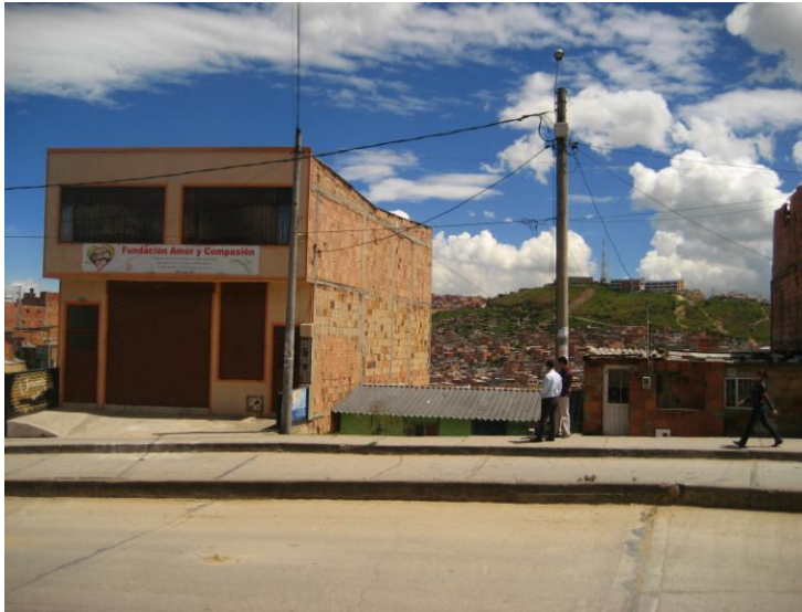
Fig. 89. Fachada de la Iglesia asociada a la Fundación Amor y Compasión. (Fuente: Propia)
