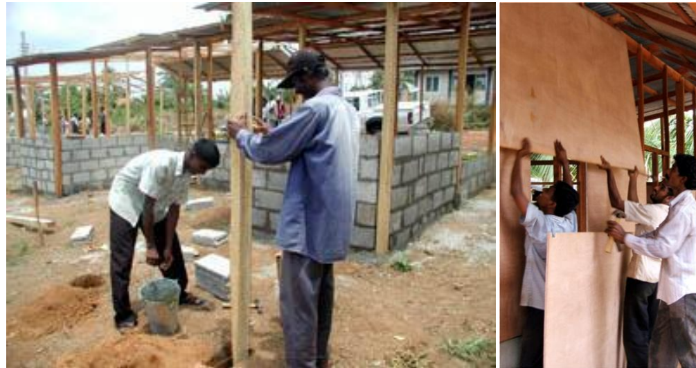
Fig. 40. Proceso de autoconstrucción dirigida para víctimas del tsunami de 2004 en Sri Lanka. (Fuente: OXFAM)
