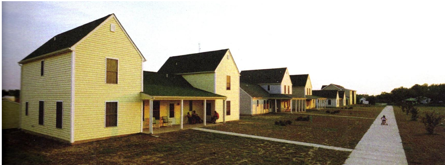
Fig. 52. Vista general del conjunto terminado. Los porches son compartidos por dos viviendas para minimizar costos y tener este elemento característico de la manera de relacionarse de los habitantes del poblado. (Fuente: Op. Cit. DESIGN LIKE YOU GIVE A DAMN: ARCHITECTURAL RESPONSES TO HUMANITARIAN CRISES. ).
