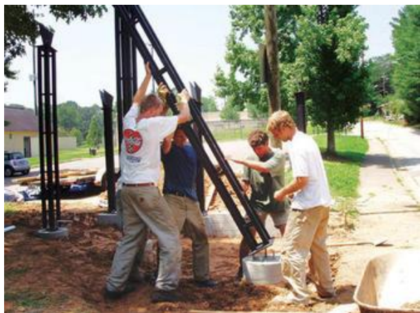
Fig. 37. Montaje de la estructura para el paradero de bus en Shiloh. (Fuente: Design Corps)
