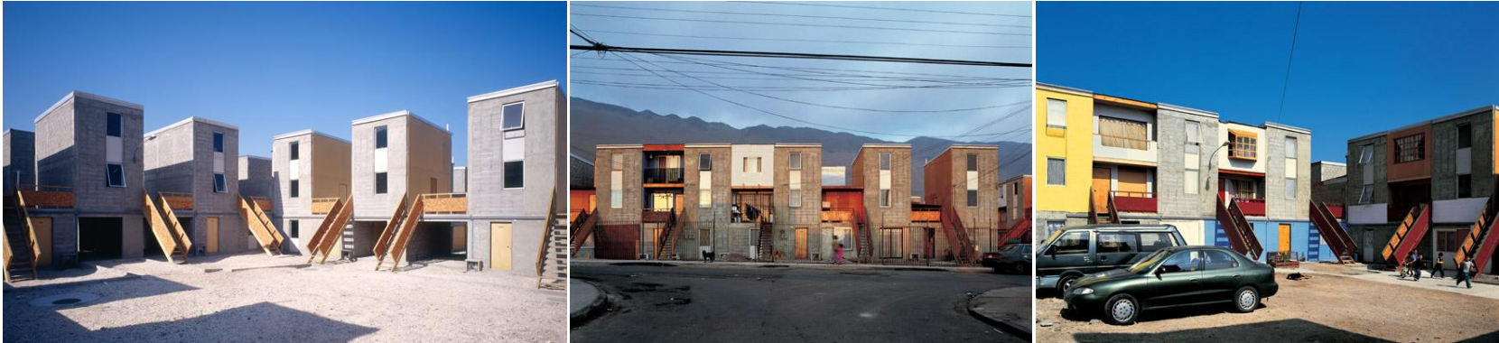
Fig. 56-58. Imágenes de distintas etapas del proyecto terminado. A la izquierda como se entregaron las casas y al centro y a la derecha tras la ocupación y el crecimiento planificado. (Fuente: ELEMENTAL)
