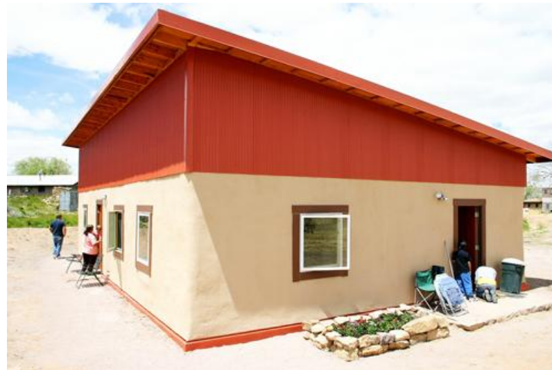
Fig. 47. Albergue terminado. (Fuente: Red Feather development Group).
