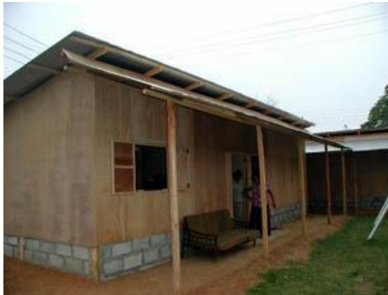
Fig. 41 Las casas terminadas. (Fuente: OXFAM)
