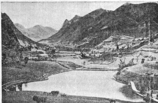
ASTURIAS. SOMIEDO. «EL VALLE DEL AJO». EMBALSE DE LA HIDROELÉCTRICA DEL CANTÁBRICO.
