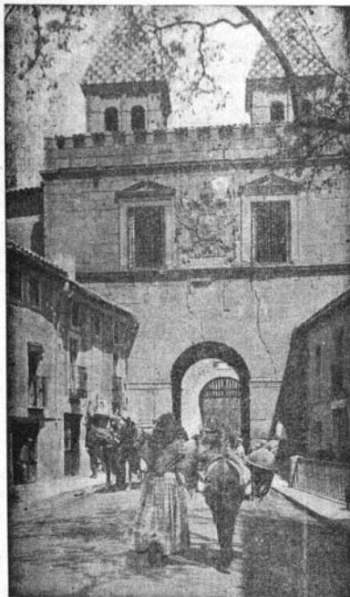
FACHADA INTERIOR DE LA PUERTA DE BISAĞRA.
