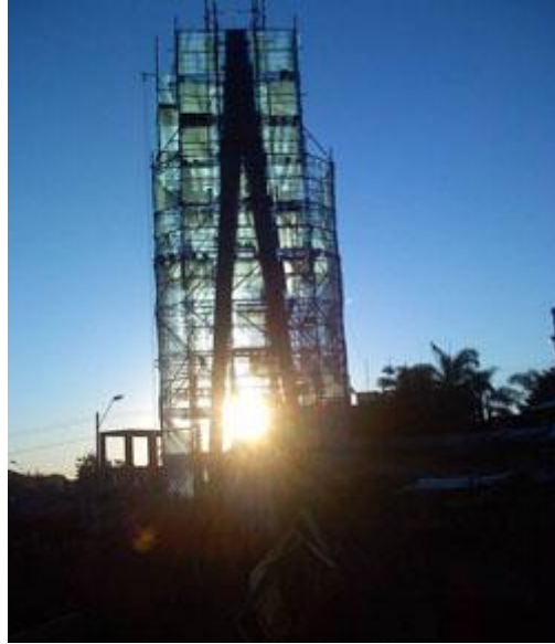
Foto 3.2.2.2: Construcción de la escultura de Yutaka Toyota. Fuente: http://images.google.com.br
