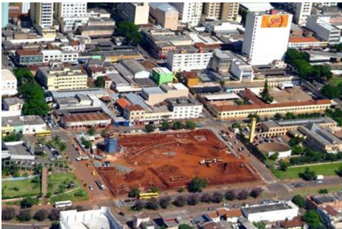
Foto 3.2.2.1: Vista del inicio de la obra de la Plaza de Japón. Fuente: http://images.google.com.br
