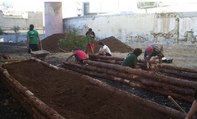
Imagen 22: Construyendo los bancales.
