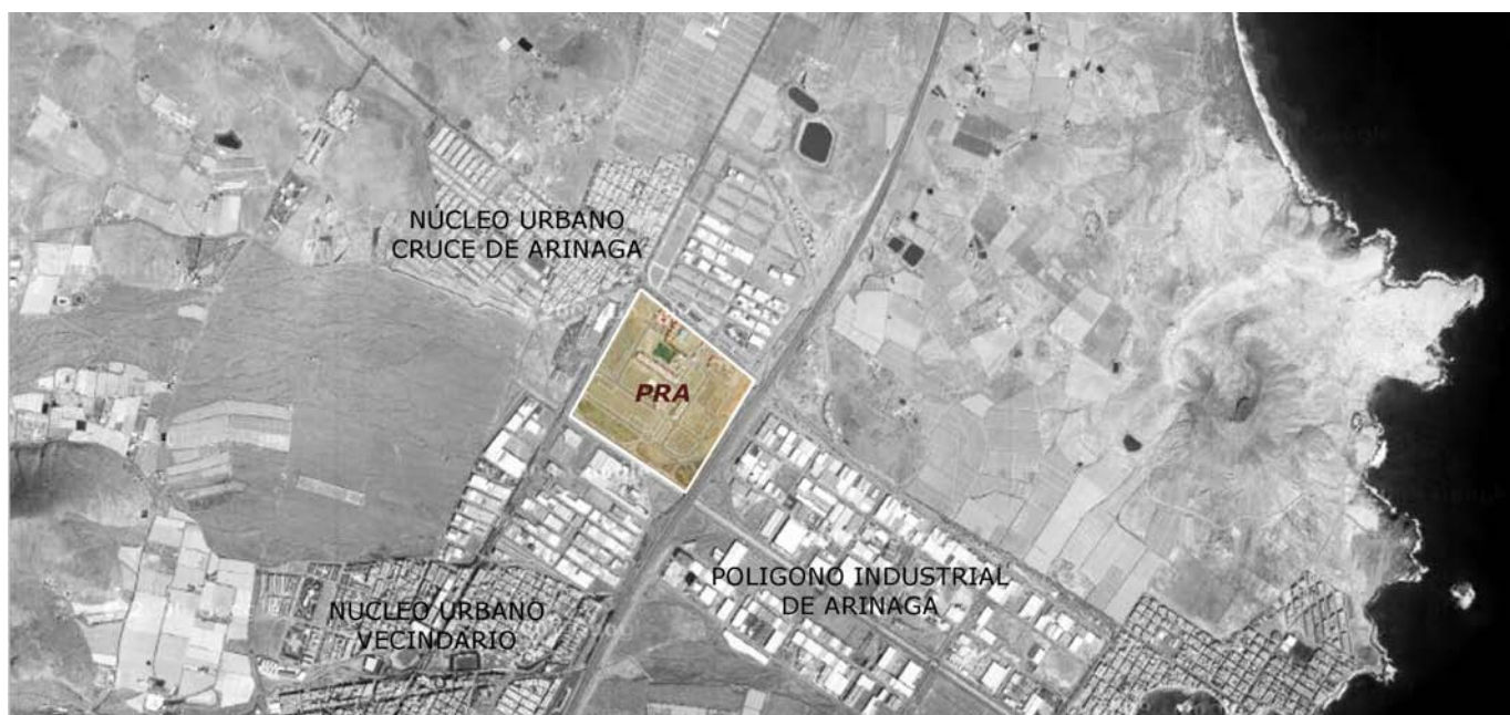
Imagen 29: Situación del Polígono Residencial de Arinaga rodeado por el Polígono Industrial, la autopista, y, al otro lado de la carretera general GC-191, el núcleo urbano del Cruce de Arinaga.
