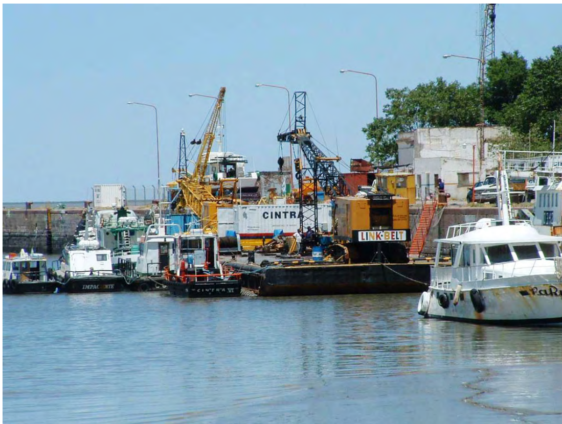
FIGURA N° 9 VISTA DEL MUELLE DE PUERTO ROSALES
