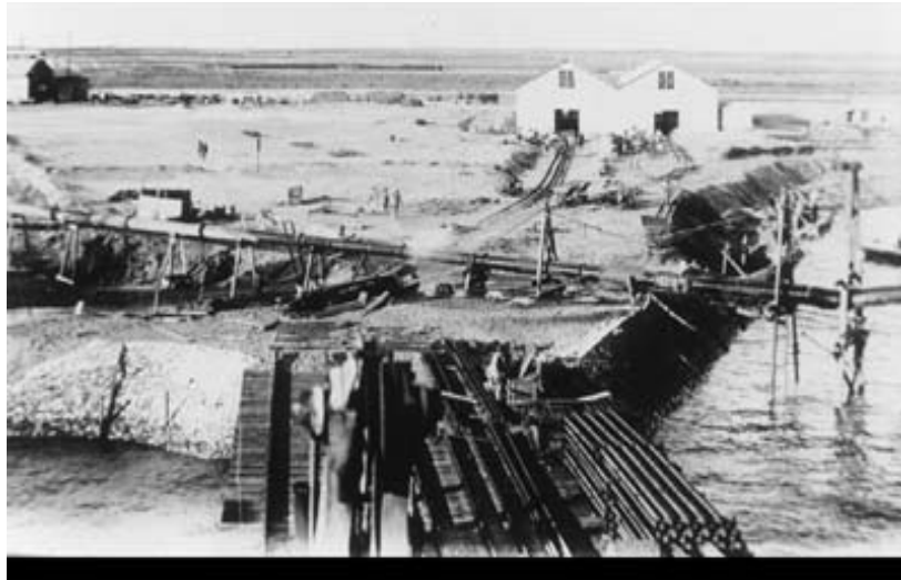
Vista aérea de las obras del puerto, 1914 (AGN). Fuente: Archivo Histórico Municipal de Punta Alta
