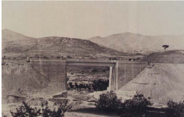
8.- Viaducto de Monóvar, Alicante.
