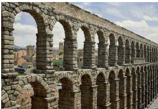
4.- Acueducto de Segovia. Declarado Monumento en 1884.
