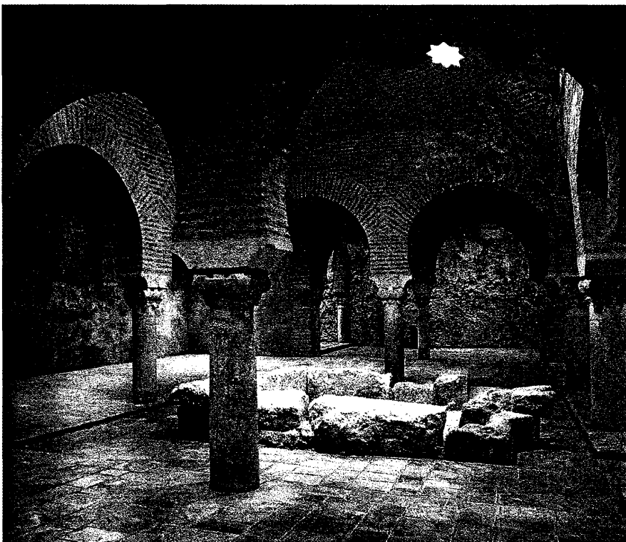
Baños públicos de Jaén.
