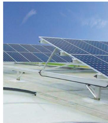
Fig. 2.4 Estructura de aluminio para soporte de módulos en campo y en techo plano.(Fuente 3)
