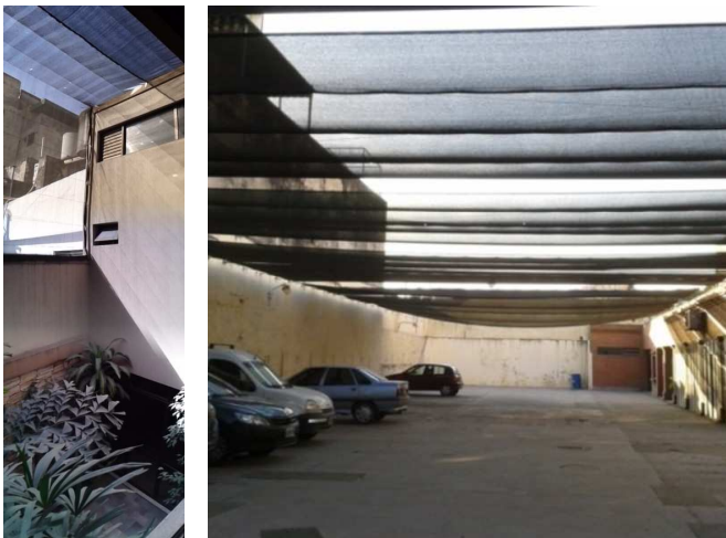
Fig 8.6-8.7. Comparación de sombra arrojada por pérgola y toldo o mediasombra en invierno y verano.
