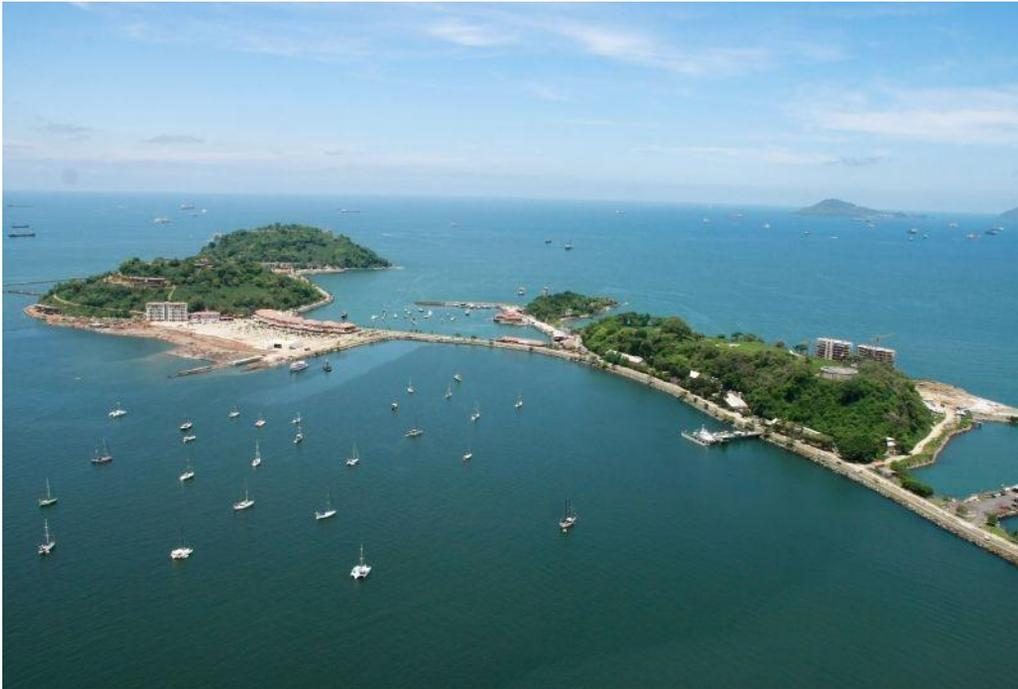
Esta calzada fue una vía construida en 1913, con rocas excavadas del Corte Culebra, durante la construcción del Canal de Panamá. Fue construido para proteger la entrada al canal, uniendo cuatro islas en el océano pacifico, formando un pequeño archipiélago. El lugar fue transformado en una atracción turística, y en espacio publico donde las personas vas a recrearse, con vista al Canal de Panamá y al centro de la ciudad.
