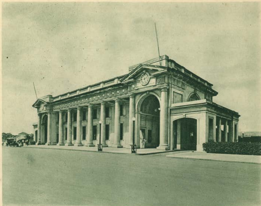
Ciudad-Panamá — Estación del Ferrocarril
