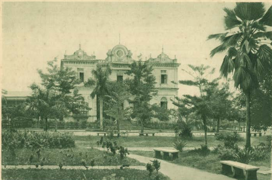
Ciudad-Panamá — Escuela República de Chile. Tipo de edificio para Escuela Primaria Urbana
